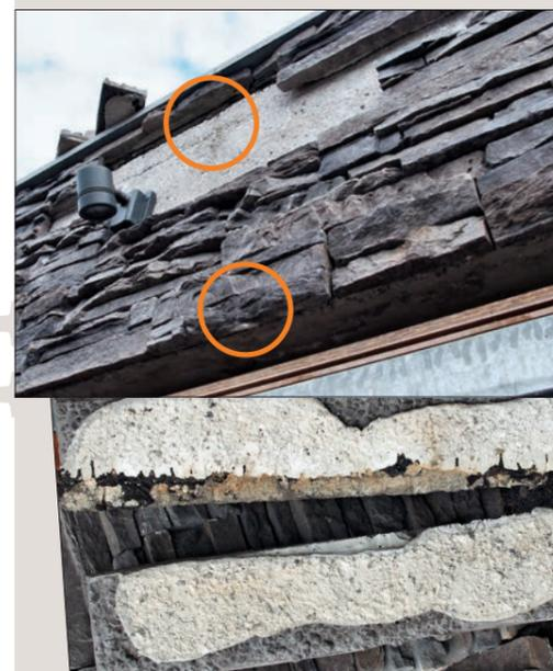
**12. DÉCOLLEMENT EN PRÉSENCE D'UNE PELLICULE DE FINITION.** L'utilisation d'un traitement de surface imperméabilisant au lieu d'un traitement imprégnant en profondeur a provoqué le décollement ; de plus, il manque aussi la double couche de **Geocoll®**.
