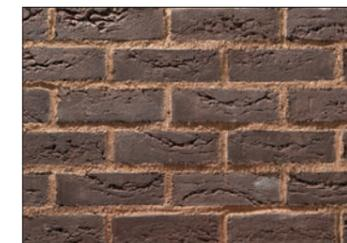
*Certaines finitions possibles avec GeoBi/F grain fin sur brique de parement.*
