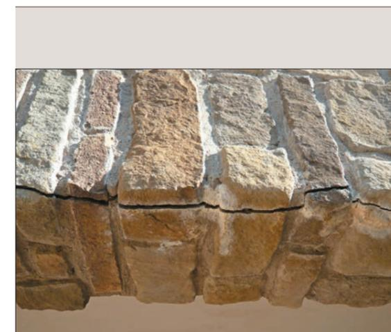
La photo montre la rupture causée par l'absence d'imperméabilisation du support en bois. L'eau ou même l'humidité, en pénétrant, ont provoqué la dilatation des matériaux, ces derniers ont bougé et cassé la pierre au niveau des angles en se dilatant.
