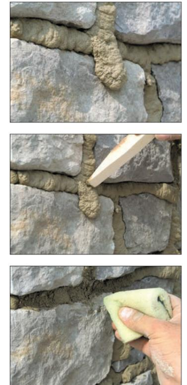
Éviter de nettoyer les coulées encore fraîches sur la pierre ; ne les enlever qu'après un premier séchage. Retirer les grumeaux de joint en excès avec une baguette en bois, puis nettoyer l'auréole restante avec une éponge mouillée en évitant de passer là où cela n'est pas nécessaire.
