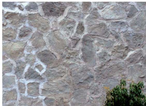
**Attention!** La couleur du mortier est sensible aux facteurs suivants: type de mise en œuvre, température, mise en œuvre ayant des degrés de séchage différents, pluie ou gel dans les 48 heures suivantes. Des changements de couleur peuvent se manifester, ainsi que l'apparition d'auréoles et de taches. (voir photo)
