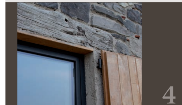
linteau de fenêtre avec poutre en bois
