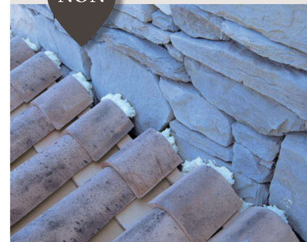
Sur la photo un exemple d'installation incorrecte
