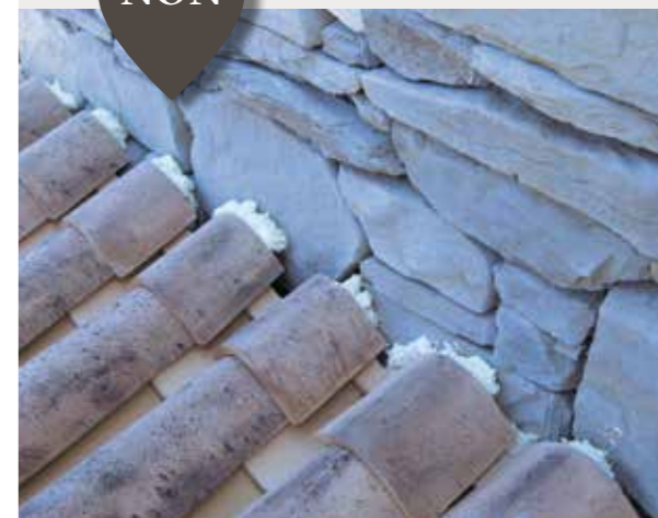
Sur la photo un exemple d'installation incorrecte
