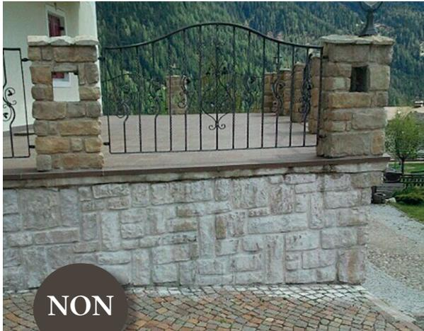
La photo en haut représente un exemple de terrasse sans canal de drainage d'eau. C'est une erreur fréquente qui cause des dommages esthétiques et de corrosion de la pierre.
